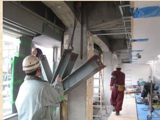
鉄骨ピース搬入
