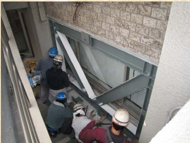
鉄骨ブレース取付
