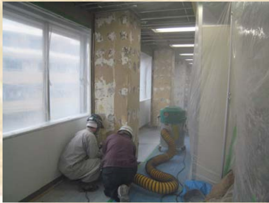
仕上げ除去工事
