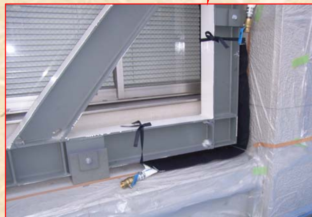
袋状繊維型枠設置
