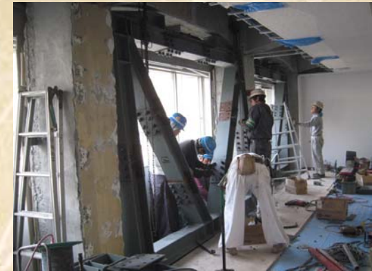
鉄骨ブレース組立
