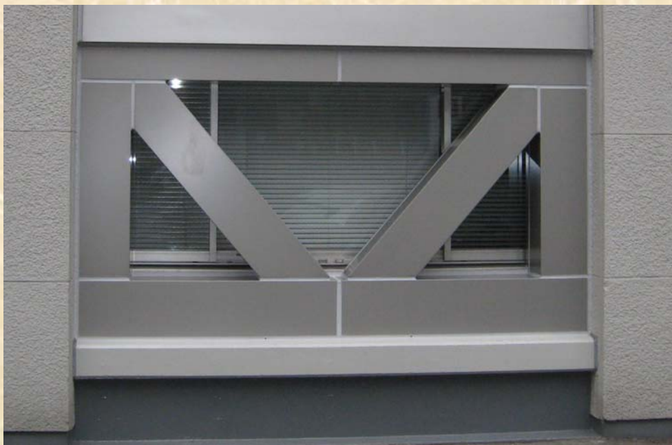
カバー仕上げ工事完成
