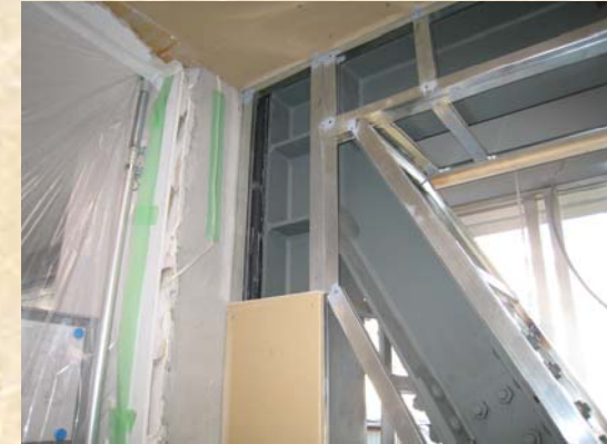
カバー仕上げ工事
